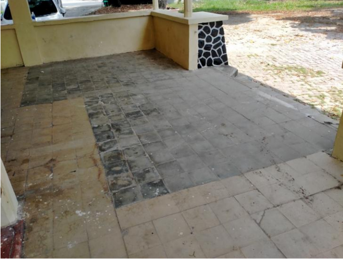
Gambar 6. Lantai di bagian teras depan (sumber: TACB Kota Metro, 2020)
