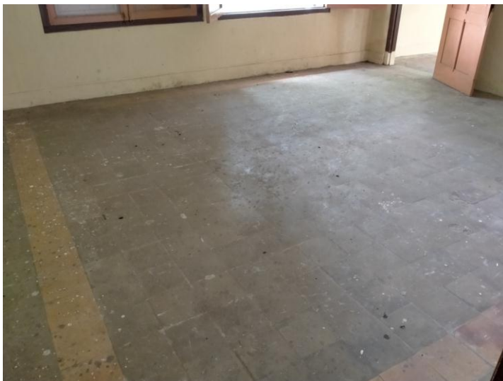
Gambar 8. Lantai di bagian kamar I (sumber: TACB Kota Metro, 2020)
