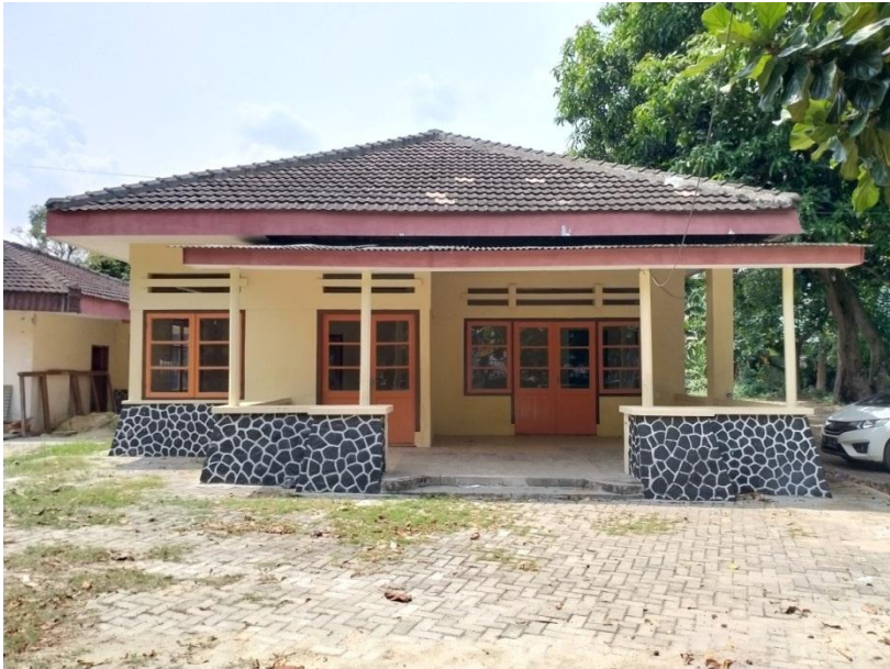
Gambar 3. Rumah Dinas Dokter tampak depan (sumber: TACB Kota Metro, 2020)
