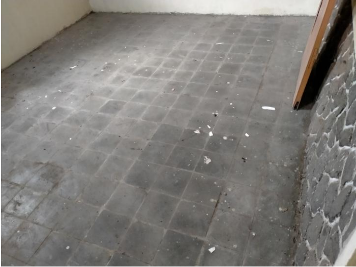
Gambar 10. Lantai di bagian kamar III (sumber: TACB Kota Metro, 2020)
