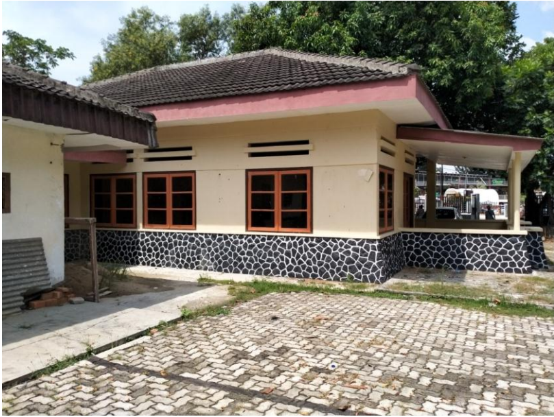
Gambar 5. Rumah Dinas Dokter tampak samping kiri (sumber: TACB Kota Metro, 2020)
