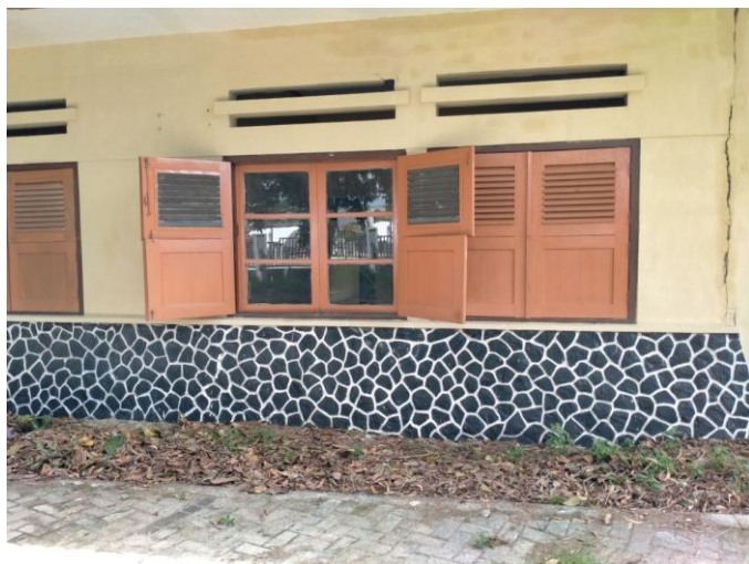
Gambar 15. Jendela ruang kamar dengan model bukaan luar-dalam (sumber: TACB Kota Metro, 2020)
