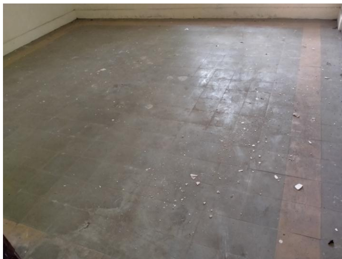
Gambar 9. Lantai di bagian kamar II (sumber: TACB Kota Metro, 2020)
